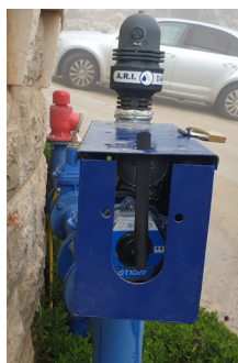
Control de temperatura
